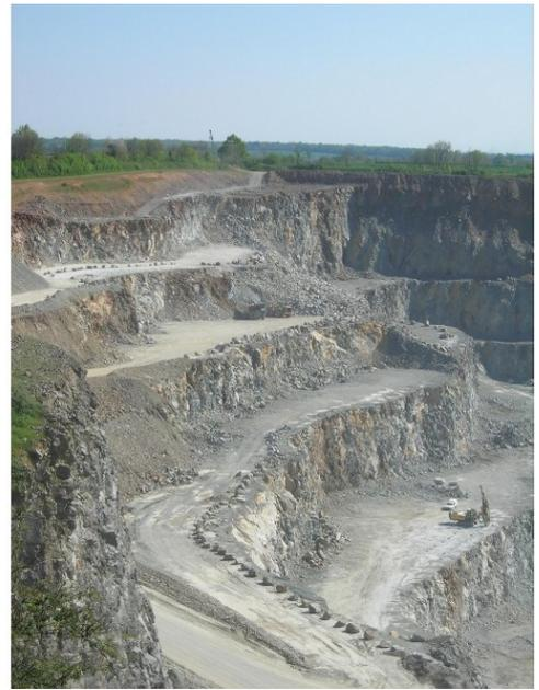
**Figure 17. Carrière des Rouleaux (Mazières-en-Gâtine).** Installations de traitement [à g.], front de taille en gradins d'une quinzaine de mètres de haut [à d.].
