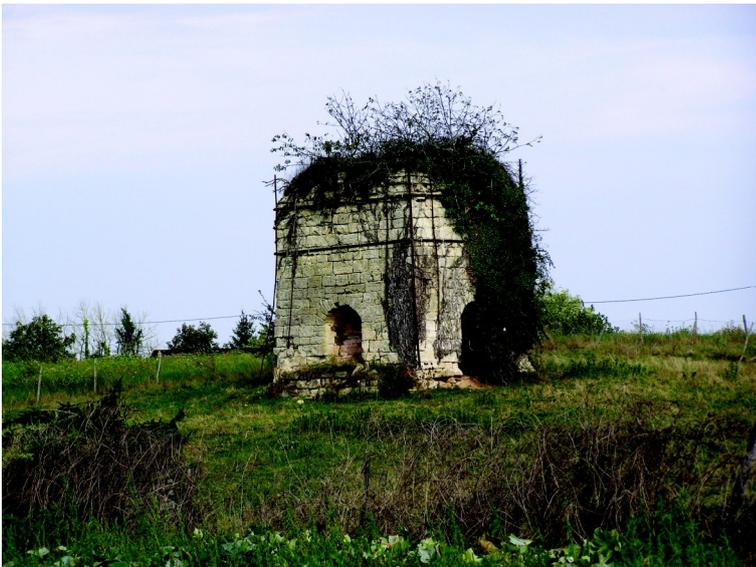
**Figure 14. Four à chaux « à feux continus » des Ajoncs Morelle (Coulonges-sur- l'A.).** Tourelle de préchauffage quadrangulaire, innovation technique due à E. Vazon (1875). [photo : Didier Poncet]
