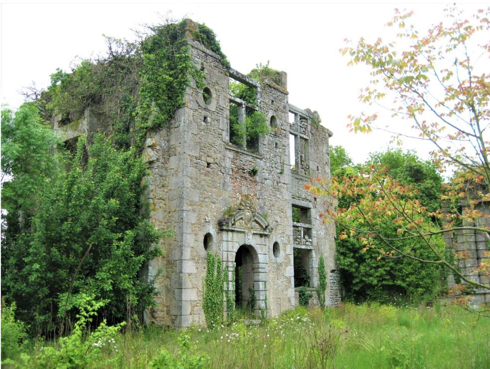
**Figure 10. Ruines du château de la Grande Meilleraye (Beaulieu-sous-Parthenay).** Chaînes d'angles, porte en plein cintre, fenêtres, cheminées adossées sont appareillés à l'aide de blocs de granite de Parthenay (faciès à texture porphyroïde de type « La Grande Meilleraye »).
