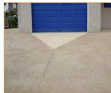
Béton poreux en entrée de garage
