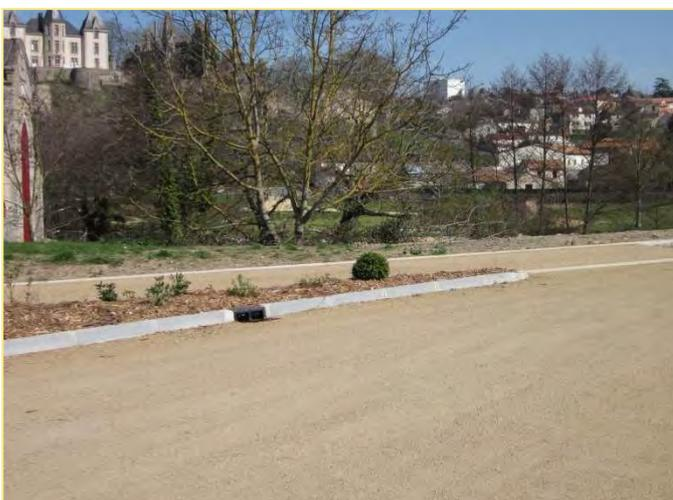
Sable stabilisé mécaniquement
