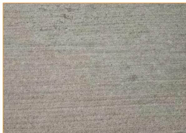
Aperçu détaillé – Béton balayé
