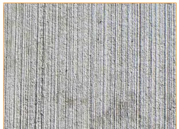
Aperçu détaillé – Béton balayé
