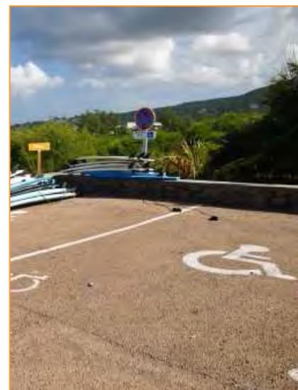
Zone de stationnement en béton poreux
