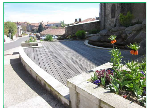
Agrémentation des abords de l'église par un platelage bois BEAULIEU SOUS BRESSUIRE
