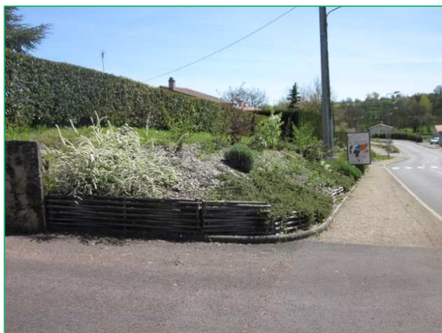
Fascines en bordure de talus - BEAULIEU SOUS BRESSUIRE
