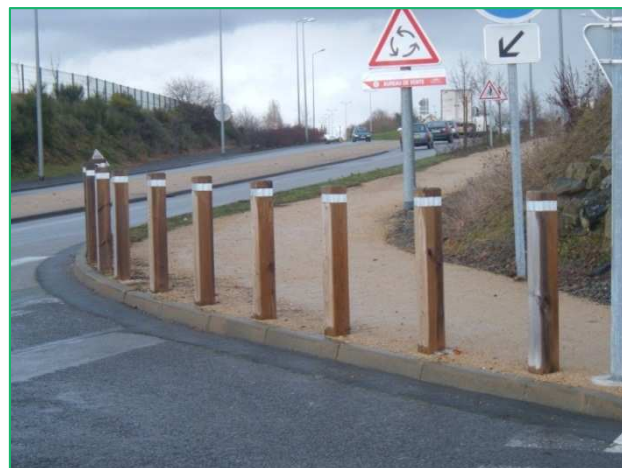
Bornes en bois en bordure de cheminement piéton PARTHENAY
