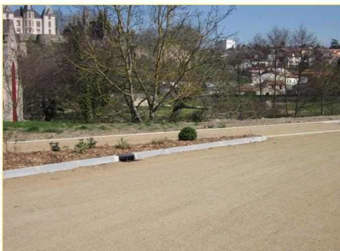
Sable stabilisé mécaniquement
