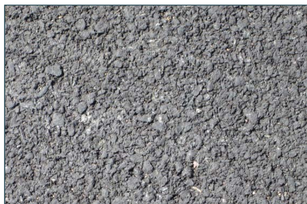
Aperçu détaillé d'enrobé noir
