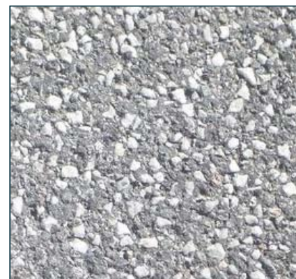
Aperçu détaillé d'enrobé grenaillé
