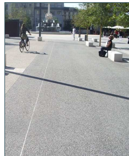
Zone mixte en enrobé grenaillé
