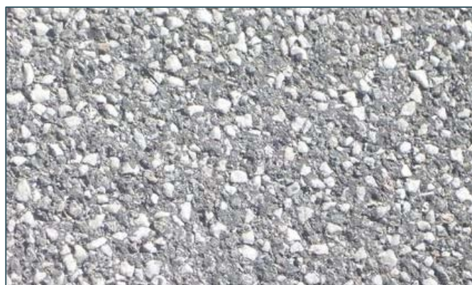
Aperçu détaillé d'enrobé grenailé
