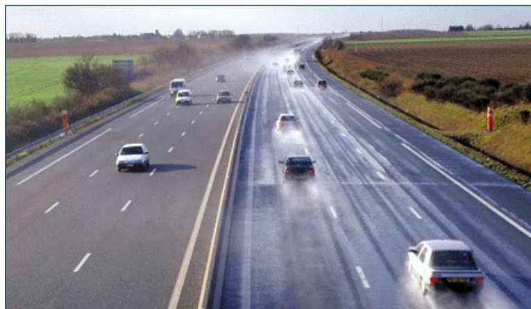
Chaussées d'autoroute avec et sans enrobé drainant
