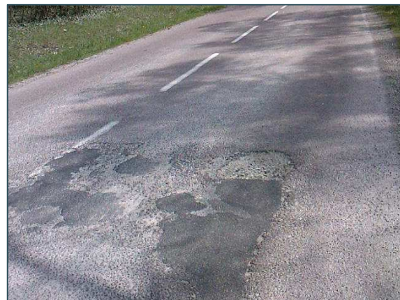
Nid de poule et réparations sur enrobé noir
