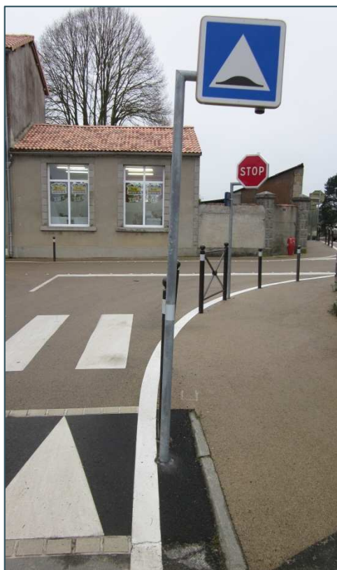
Zone piétonne en enrobé coloré - BRESSUIRE
