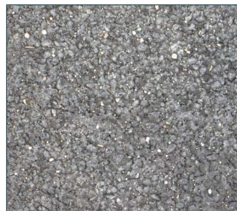
Aperçu détaillé d'enrobé noir
