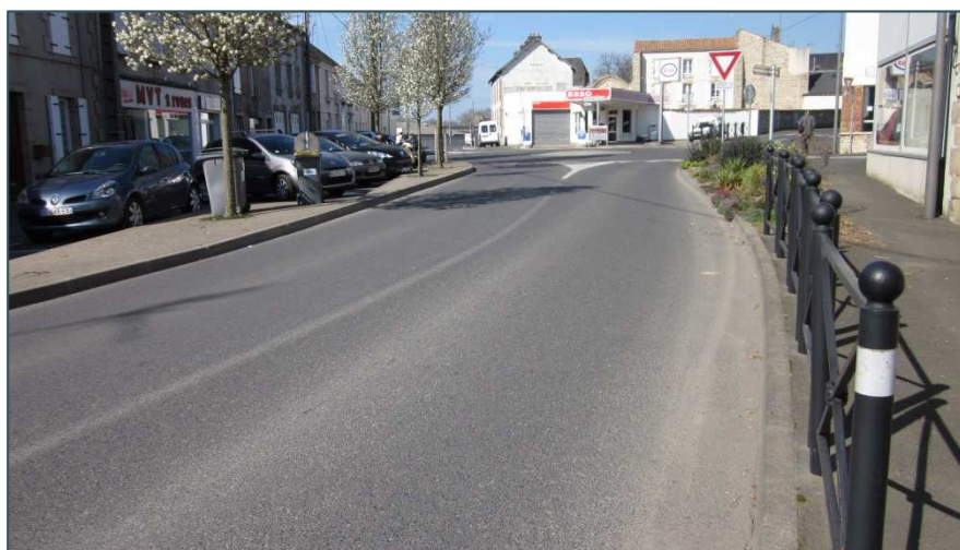
Route avec revêtement en enrobé noir - BRESSUIRE
