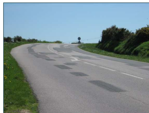
Réparations sur enrobé noir
