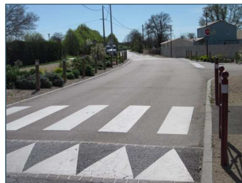
Enrobé coloré sur carrefour SAINT PORCHAIRE
