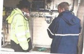
Les techniciens de GRDF ont démarré le poste d'injection, qui permet d'acheminer le biogaz dans le réseau de gaz naturel.
