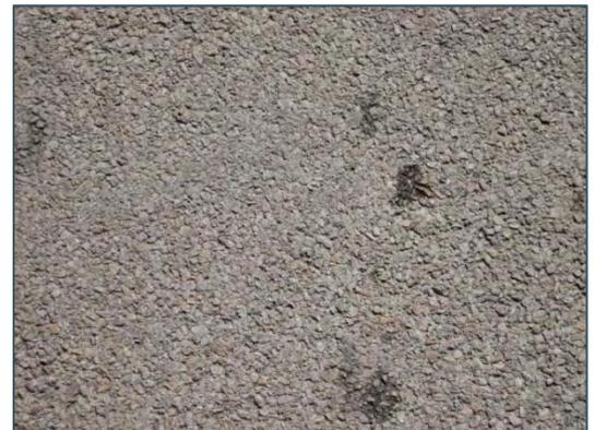
Aperçu détaillé d'enrobé coloré avec taches d'hydrocarbures
