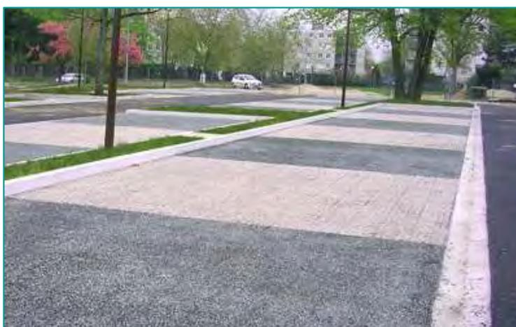
Revêtement alvéolaire utilisé pour la réalisation d'une zone de stationnement empierrée et drainante
