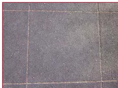
**Les sols amortissants coulés sur place** sont également en **granulats de caoutchouc**. La sous-couche est en caoutchouc noir alors que **la couche de surface est colorée**. Cette dernière est coulée sans joint. **Elle est poreuse pour permettre l'évacuation des eaux pluviales**. L'épaisseur du revêtement varie entre 20mm et 100mm pour une hauteur de chute respective de 1m à 3m. Pour un même sol amortissant, il est possible d'obtenir différentes épaisseurs.
