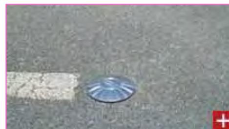
Suivant le modèle et sa finition, le clou permet de réduire la signalisation le jour tout en étant visible de nuit (reflet de la lumière).
