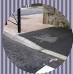
Une bordure est un élément vertical ou incliné bordant les zones de circulation piétonnes ou véhicules, pouvant constituer une partie du dispositif d'écoulement des eaux pluviales.
