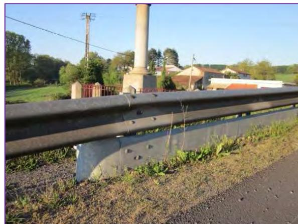
**L'écran moto** : Il empêche les motards, lors d'une chute, de passer sous la glissière et de heurter les supports. Il atténue donc la gravité **des blessures**.
