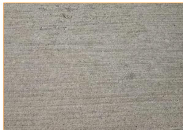
Aperçu détaillé – Béton balayé
