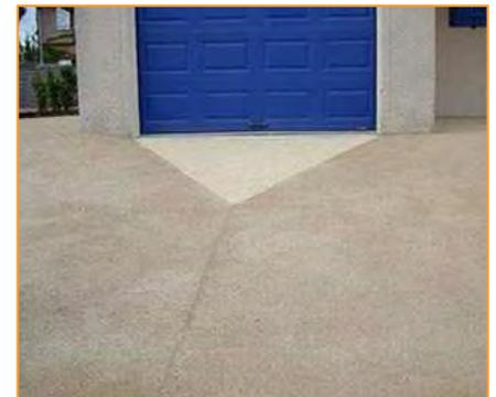
Béton poreux en entrée de garage
